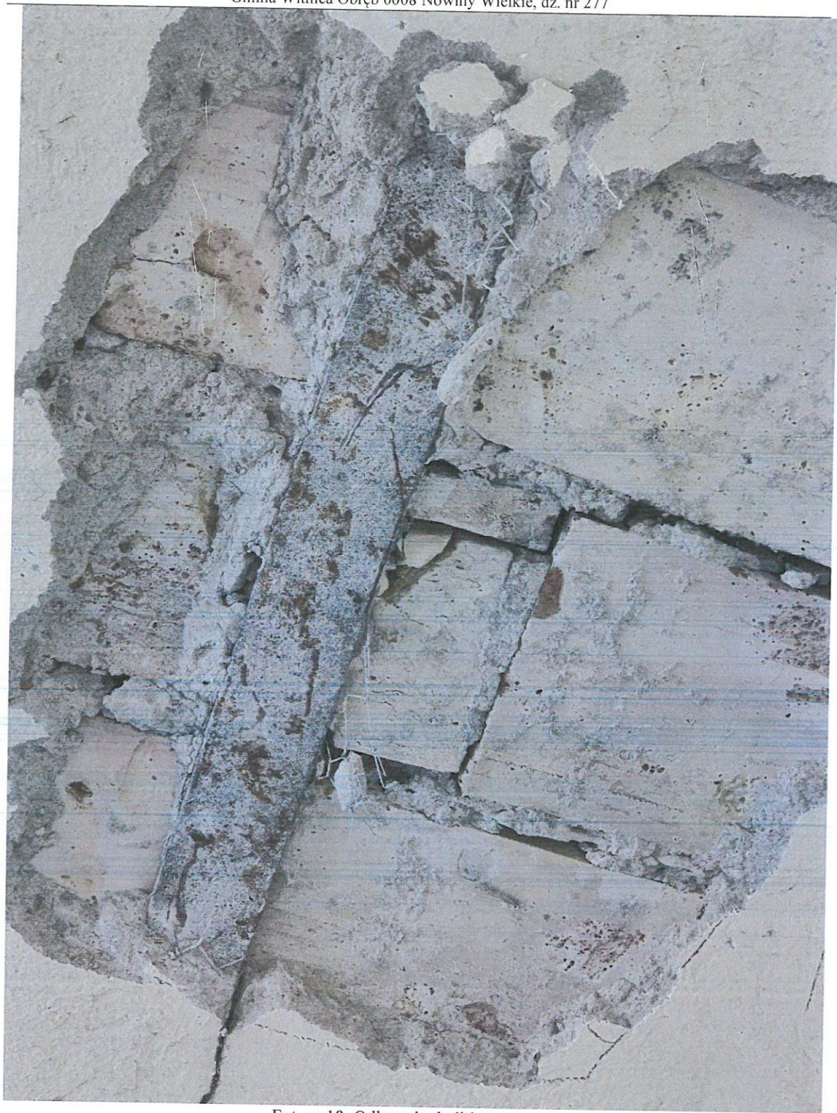
Fot. nr 18 Odkrywka belki stropowej
