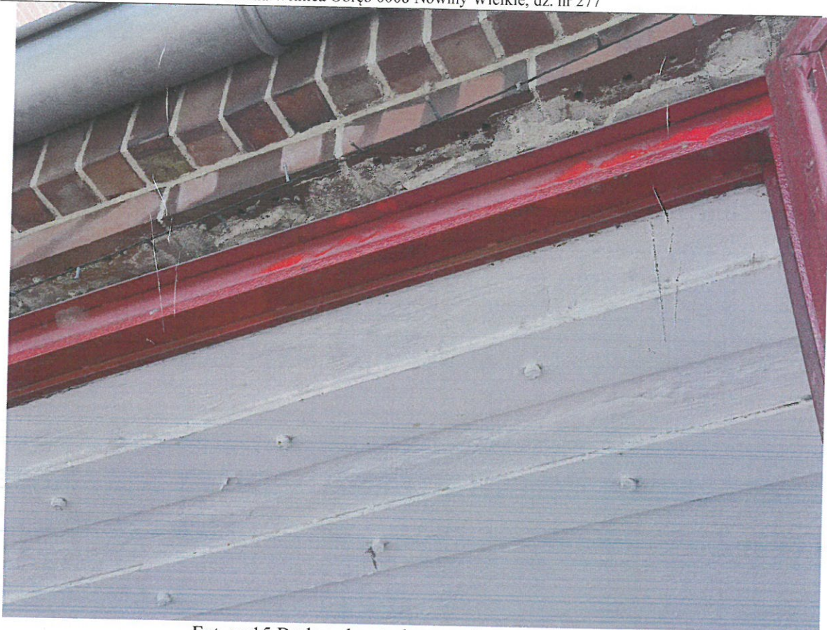
Fot. nr 15 Brak nadproża bramy od strony zachodniej
