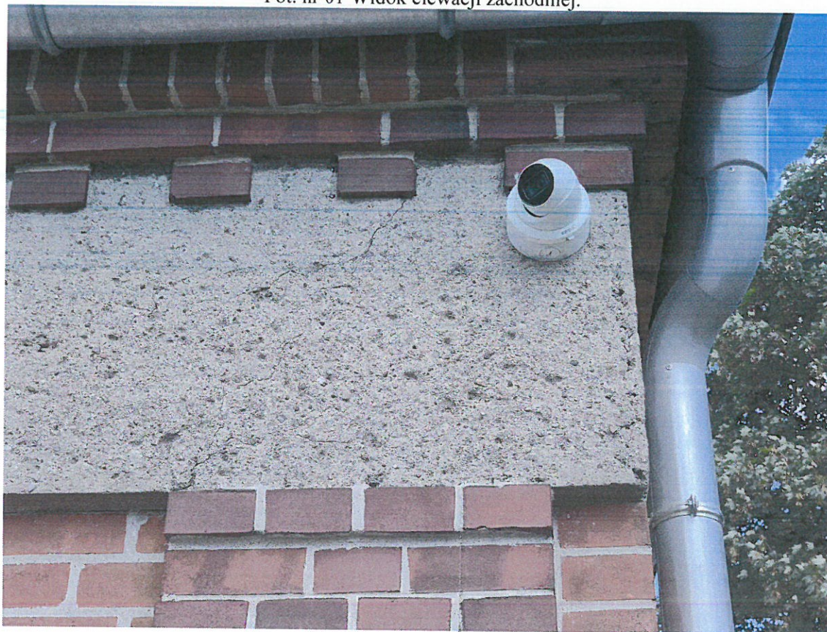
Fot. nr 02 Widok elewacji - uszkodzenia.
