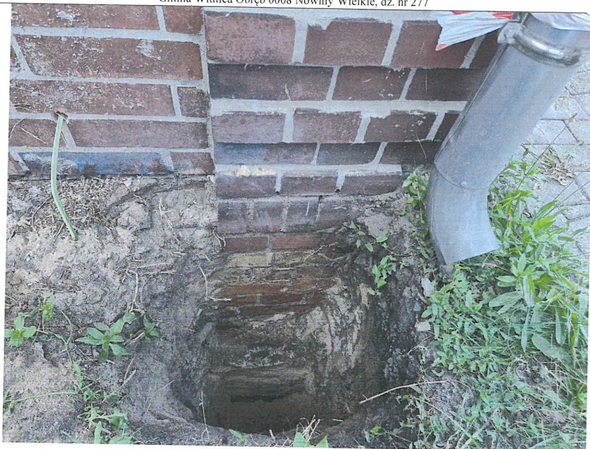
Fot. nr 11 Odkrywka fundam. nr 4
