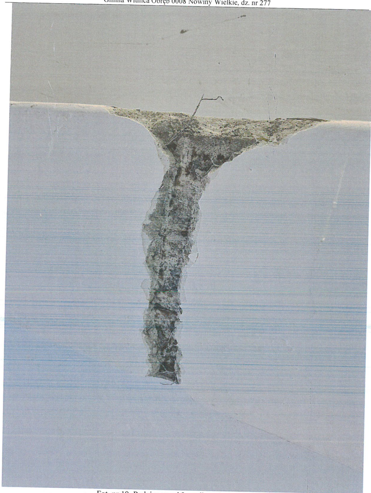
Fot. nr 19 Podciąg w osi 2 – odkrywka belek 3I180
