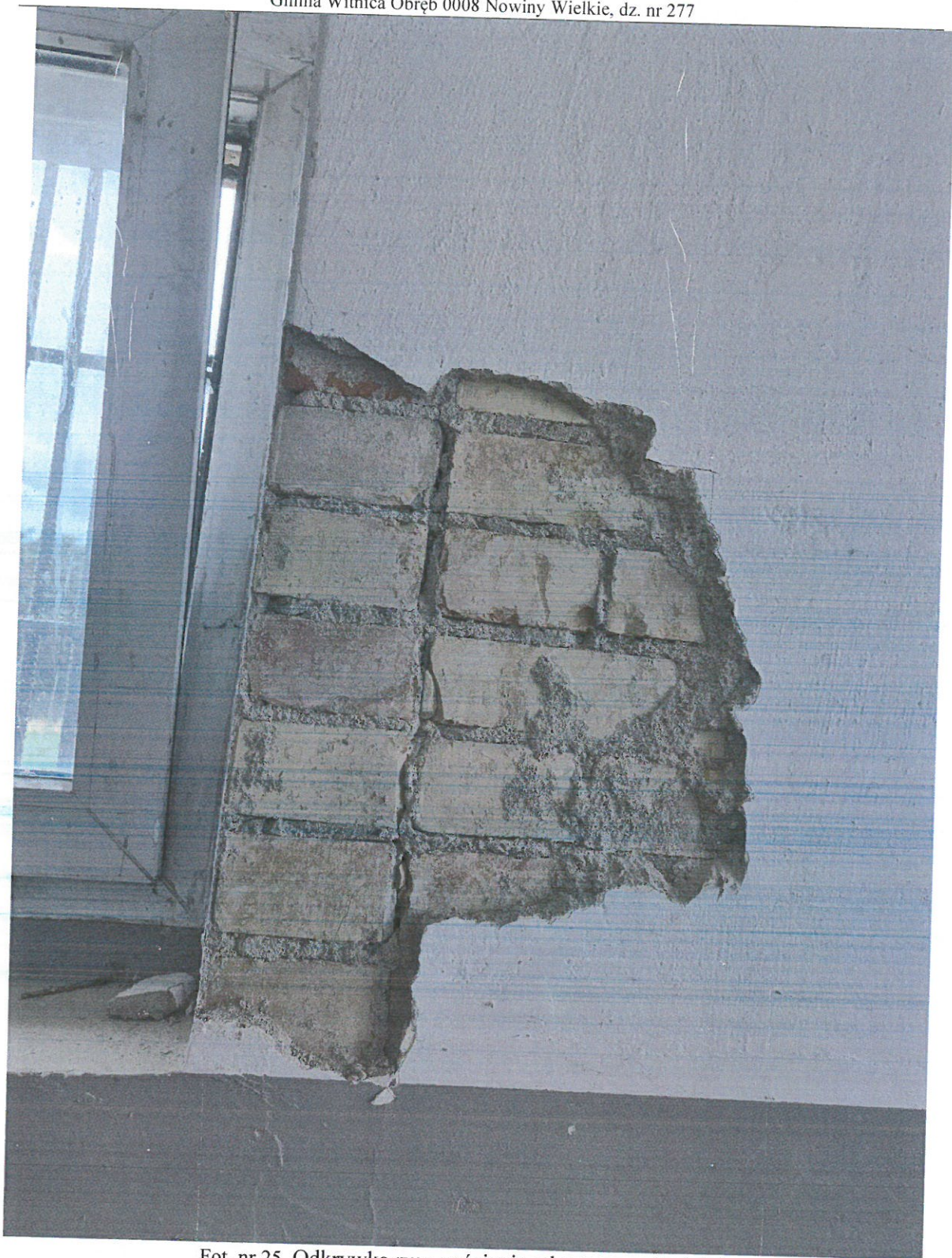
Fot. nr 25 Odkrywka rysy w ścianie od strony zachodniej
