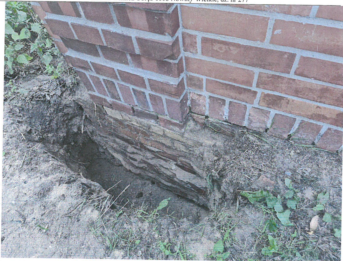
Fot. nr 09 Odkrywka fundam. nr 3
