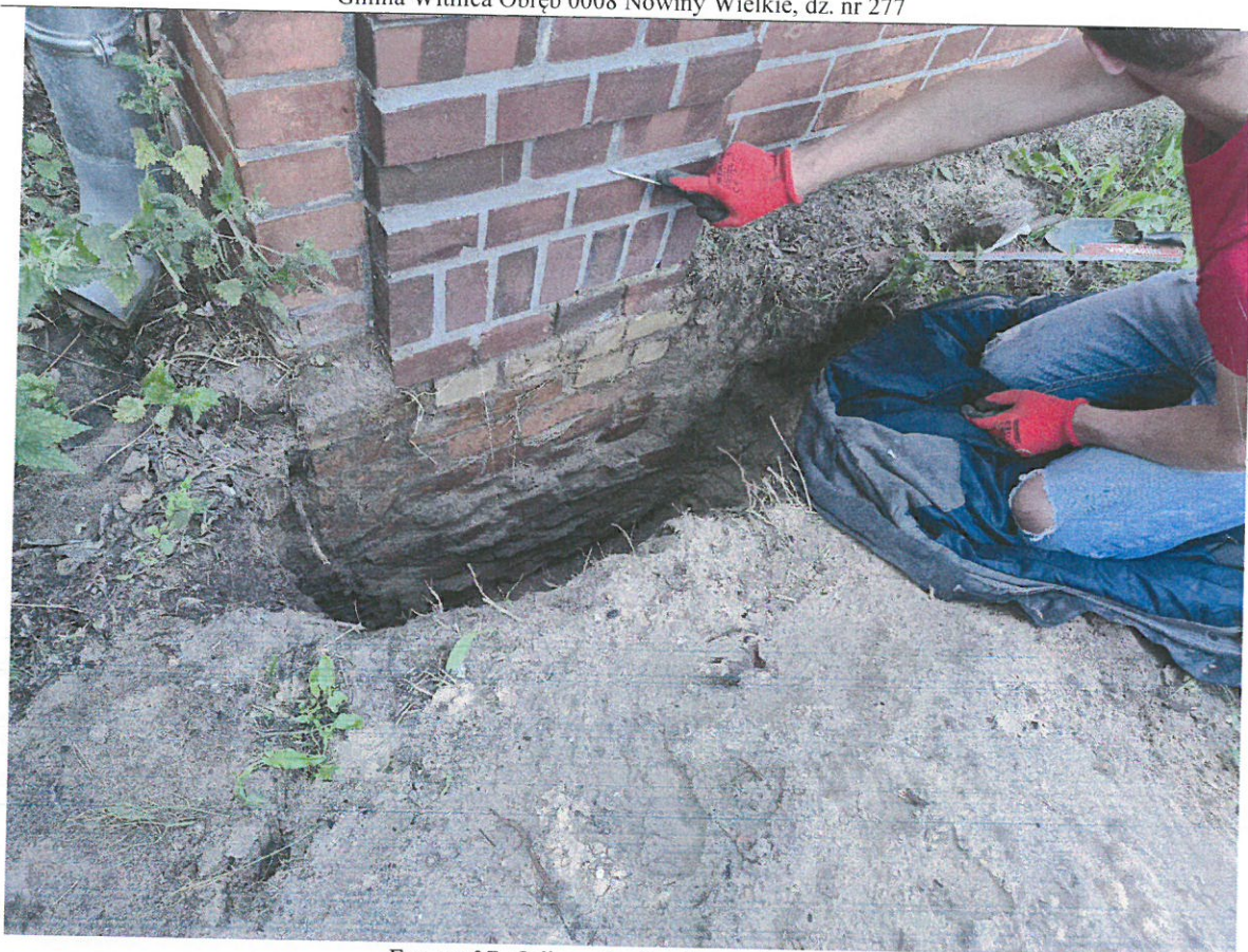
Fot. nr 07 Odkrywka fundamentów nr 2.
