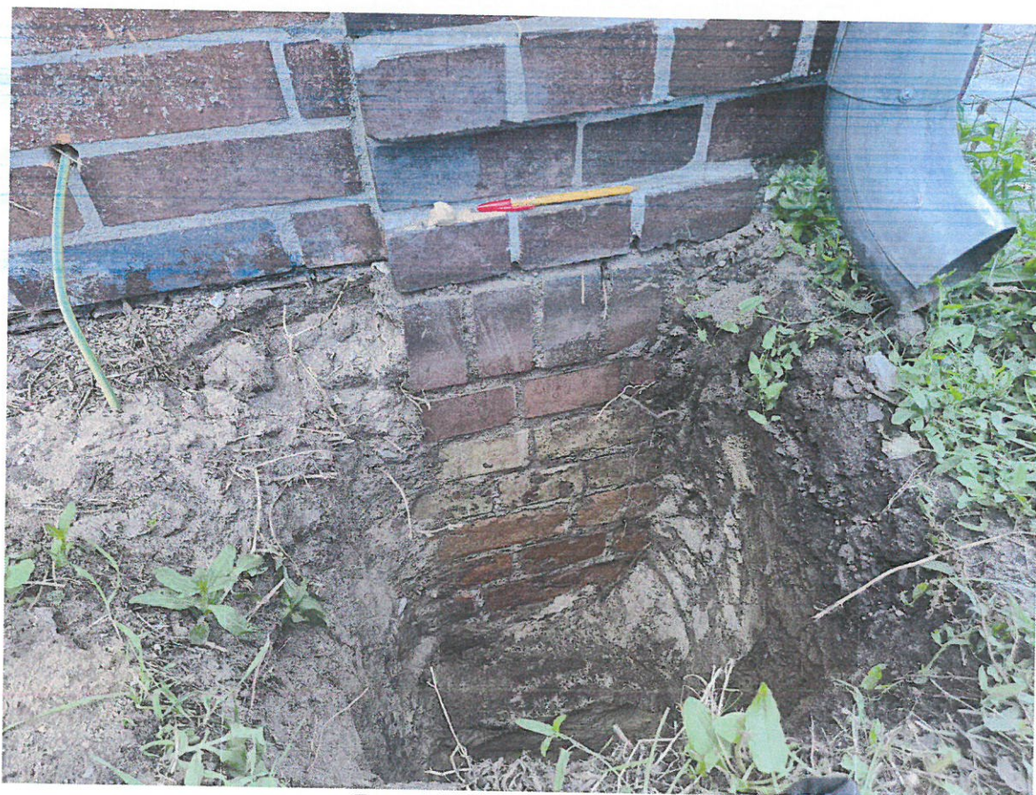
Fot. nr 12 Odkrywka fundam. nr 4
