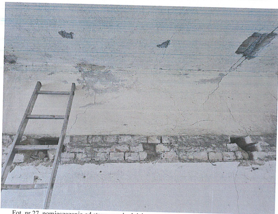
Fot. nr 26 pomieszczenie od strony wschodniej – pogrubienie ściany w osi 1 i uszkodzenia
