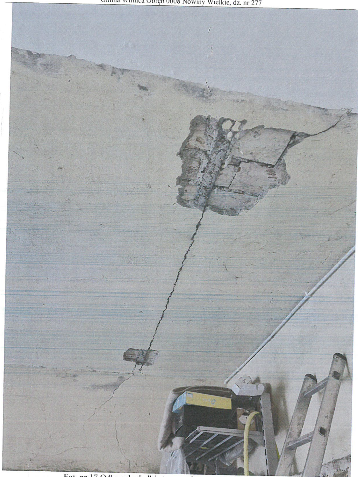
Fot. nr 17 Odkrywka belki stropowej oraz – uszkodzenia ściany
