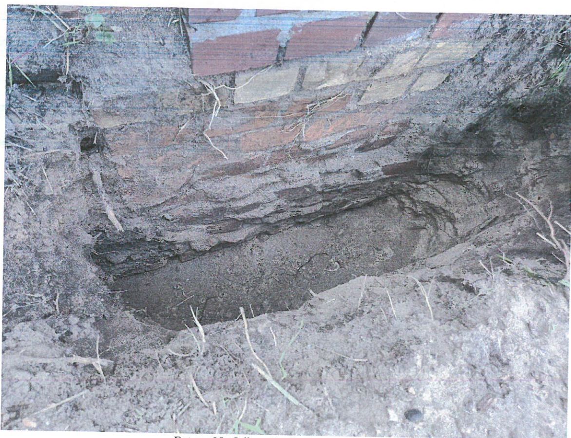
Fot. nr 08 Odkrywka fundamentów nr 02.
